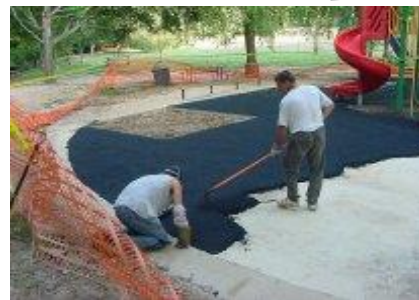
Выравнивание с помощью шпателя
